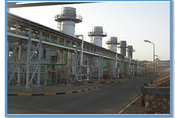
محطة توليد كهرباء شرم الشيخ
