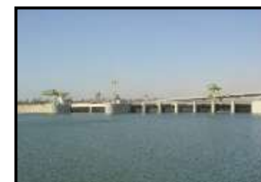
Naga Hamadi Barrage
