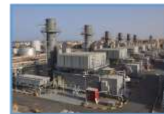
Hurghada PP 288 MW
